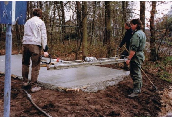
De grondplaat wordt gereed gemaakt
